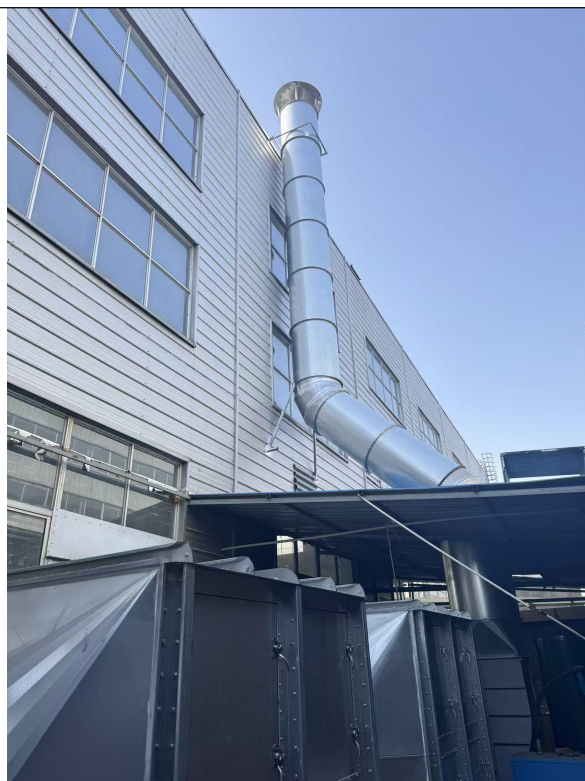
DA001 排气筒及配套废气处理设施
