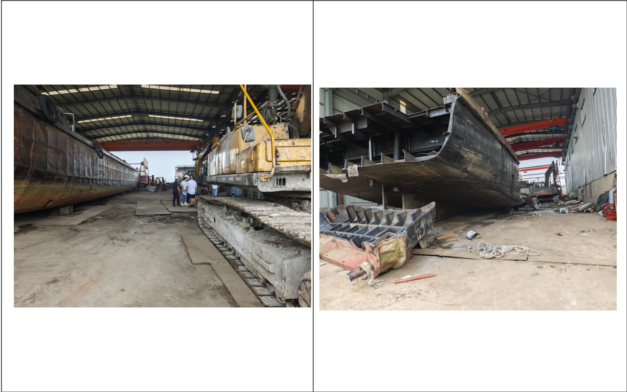
图 4-3 现场拆解及清理图
